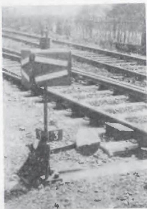
7. Výměnové návěstidlo oboustranné (souměrné) výměny ze strany „proti hrotu“
