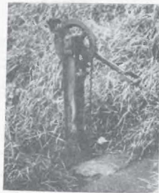
12. Místní ruční stavědlo seřadovacího návěstidla pro dovolení vjezdu z lokomotivního depa do obvodu stanice
