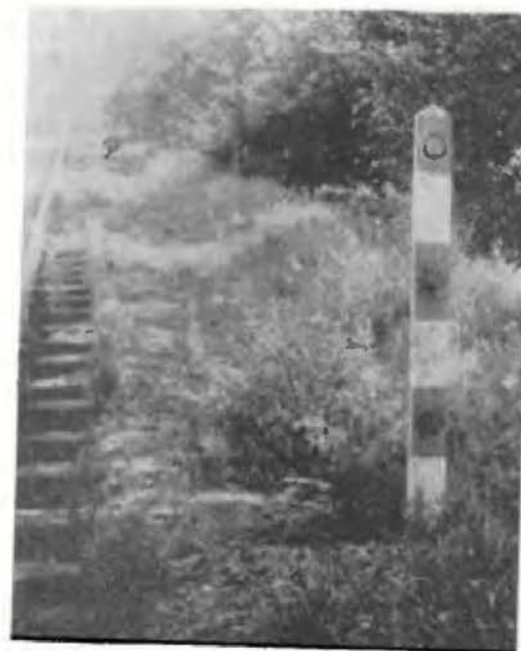
14. Pískáček. Je zřetelné osazení odrazovými skly (bílá skla v červených pruzích)
