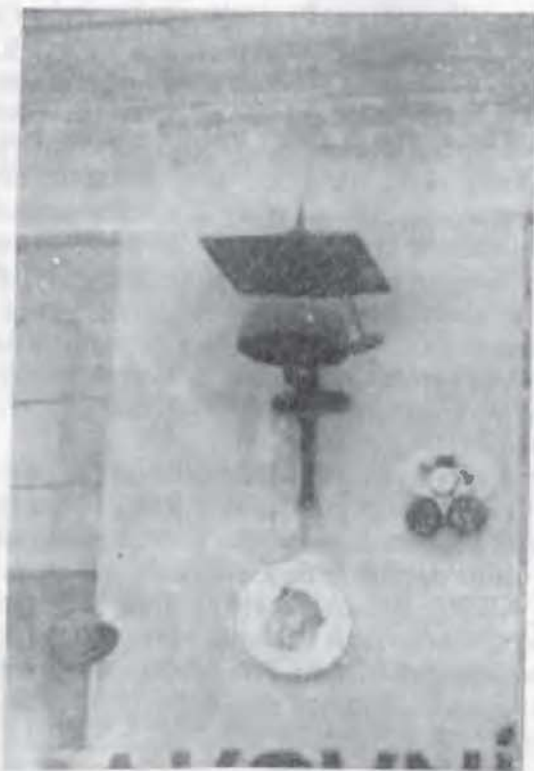
1. Signálový zvon (jednehlásý) upevněný na stěně stavědla. Drátový ovládací systém je již odmontován
