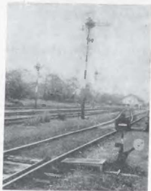
5. Část zhlaví z odjezdové strany. Na odjezdových návěstidlech je dosud znatelný mechanismus druhého ramene, odmontovaného po změně návěstních předpisů pro použití mechanických hlavních návěstidel
