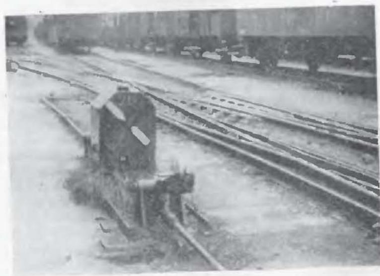
9. Návěstidlo křižovatkové výhybky. Obě části výhybky jsou ručně stavěné a jsou v základní poloze
