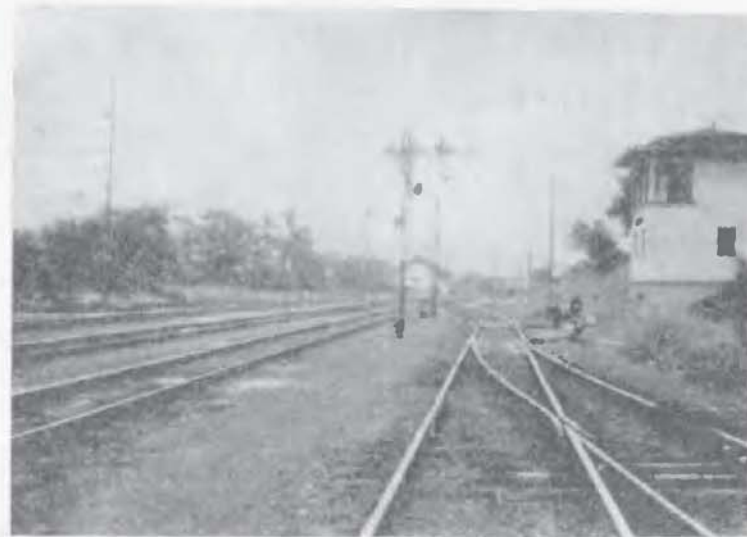
11. Skupinově osazené zhlaví mechanickými odjezdovými a seřadovacími návěstidly. Kolej přímo proti nám je záchytná kusá kolej
