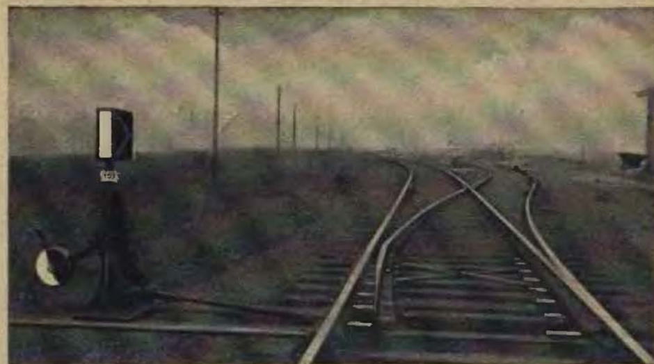
Obr. 102 Neosvětlovatelné výměnové návěstídko u jednoduché výhybky
