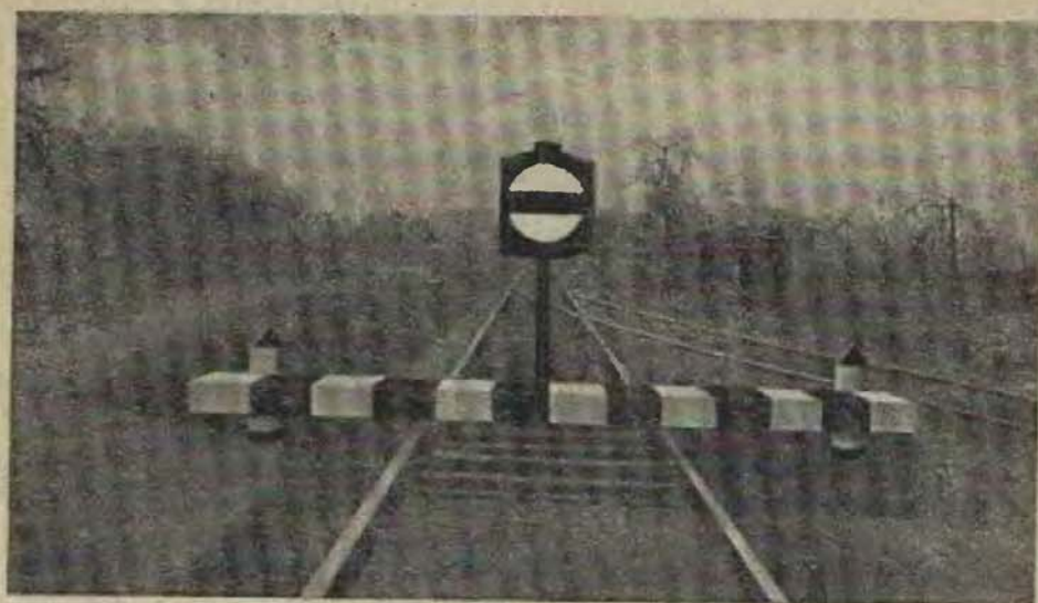
Obr. 75 Uzávěra koleje na kolejové zábraně
