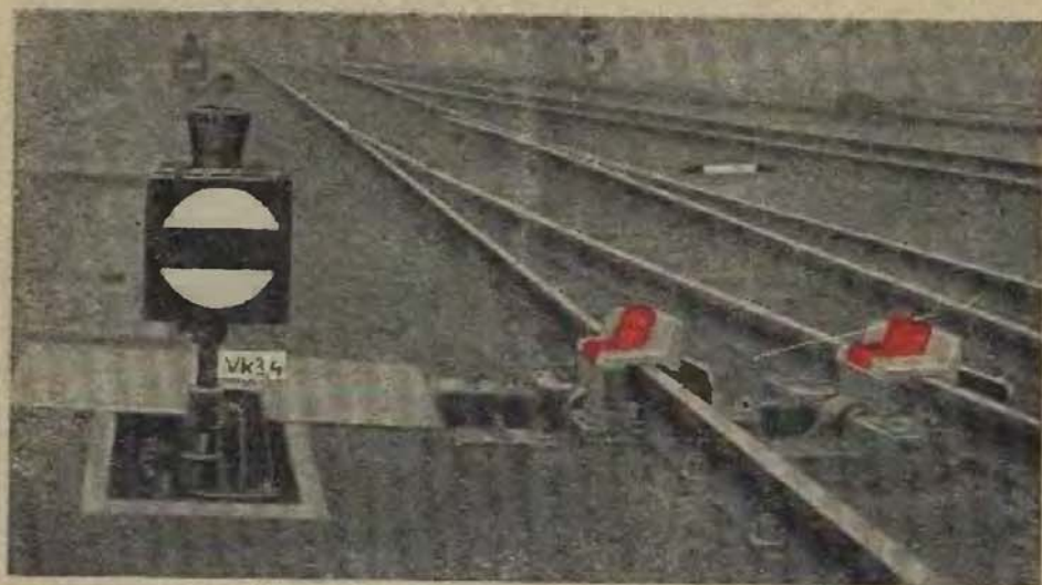
Obr. 74 Uzávěra koleje na výkolejce
